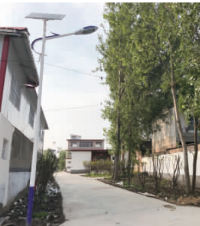
硬化后的小路上，安装上了光伏路灯。
