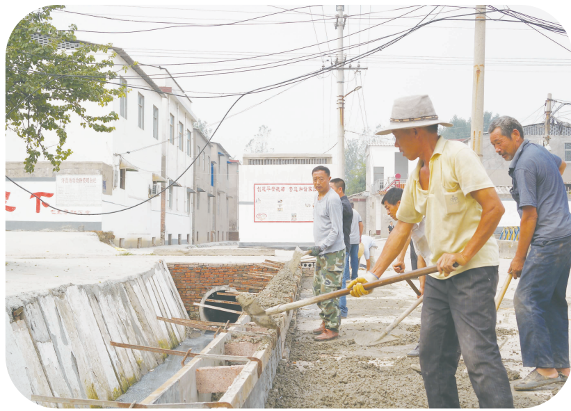
工人们正在进行排污管道混凝土浇筑。
