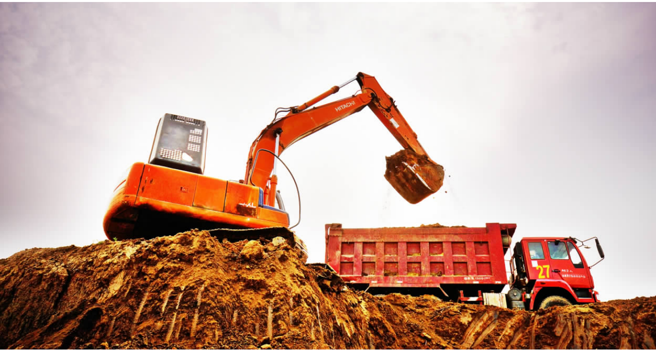
目前,灞陵湖工程进展顺利,图为大型机械正在进行湖堤土方填筑工程施工。 侯聪 摄 值班总编 许廷合 编辑 岳亚光 图片处理 冯子建
